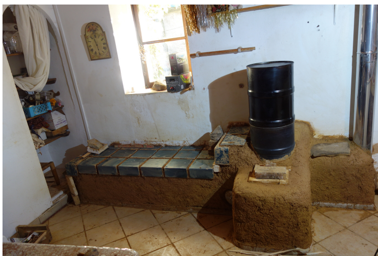
Illustration 1: Un poêle de masse Rocket avant séchage et couche de finition
